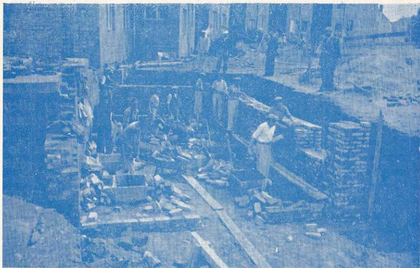
Rok 1945 — Budowa przy ul. Ujejskiego
